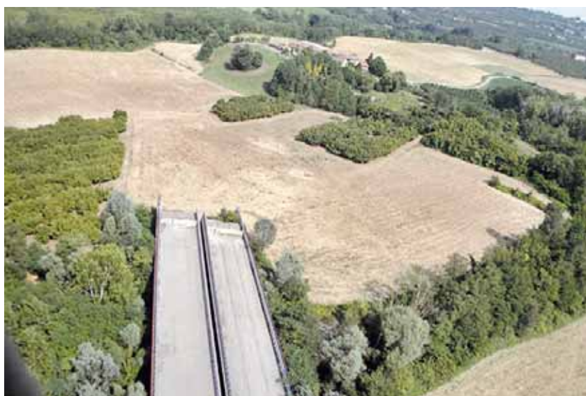
L'autostrada Asti-Cuneo che si interrompe nelle campagne cheraschesi e Manuele Isoardi capogruppo dei 5 Stelle a Cuneo nel suo intervento pro superstrada e contro l'autostrada.
