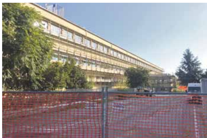
Cappotto termico per il lungo edificio dell'Itis di corso De Gasperi.
