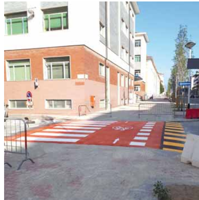
Un tratto della nuova pista ciclabile realizzata in corso Brunet che completa il collegamento est-ovest della rete ciclabile tra la stazione ferroviaria e il viale degli Angeli.
