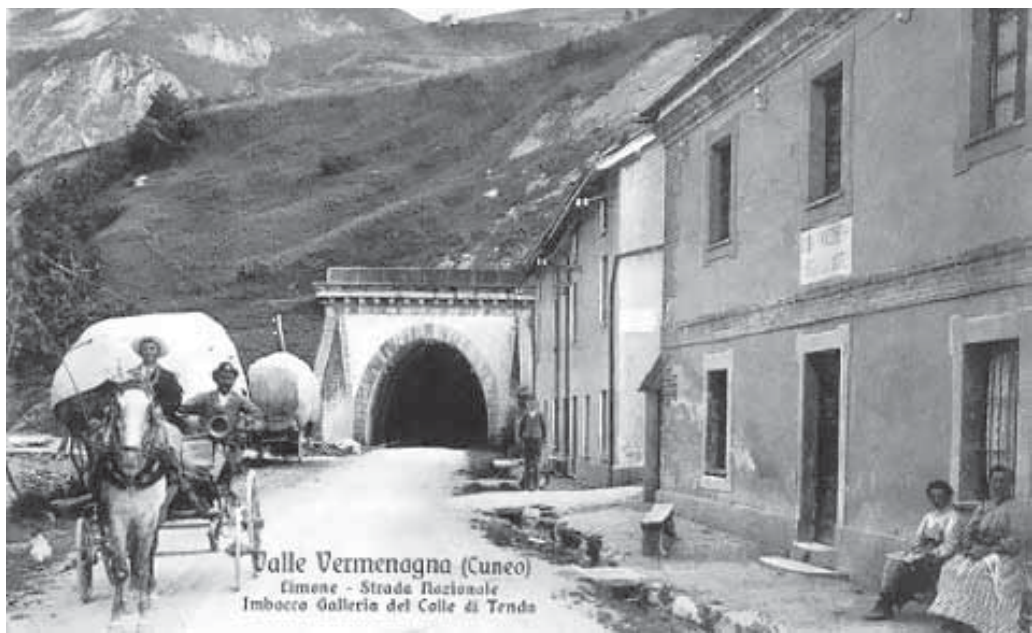
L'imbocco lato Italia.
