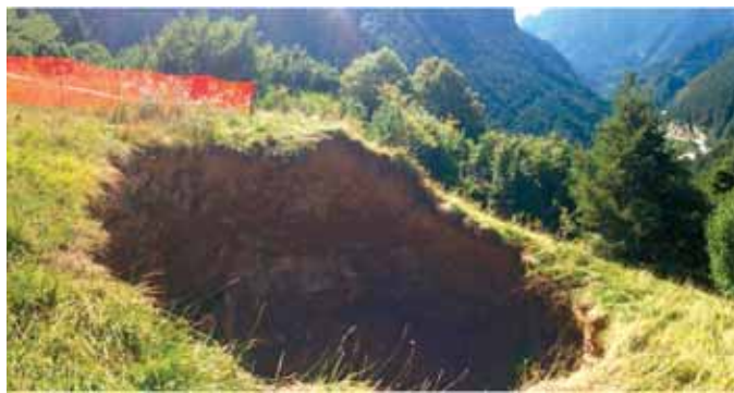
La depressione prodotta in superficie dallo scavo del tunnel. (Fig. 4)
