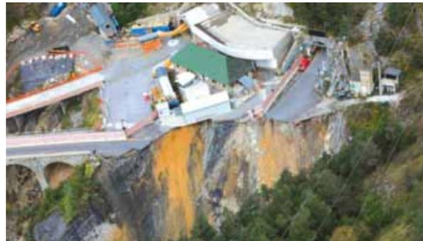
L'erosione del piazzale di uscita lato Francia a parte del Rio delle Cannelle. (Fig. 8)
